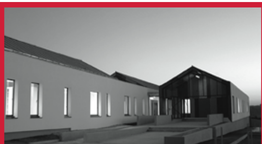
Groupe scolaire Saint-Éxupéry à Saint-Crespin-sur-Moine
